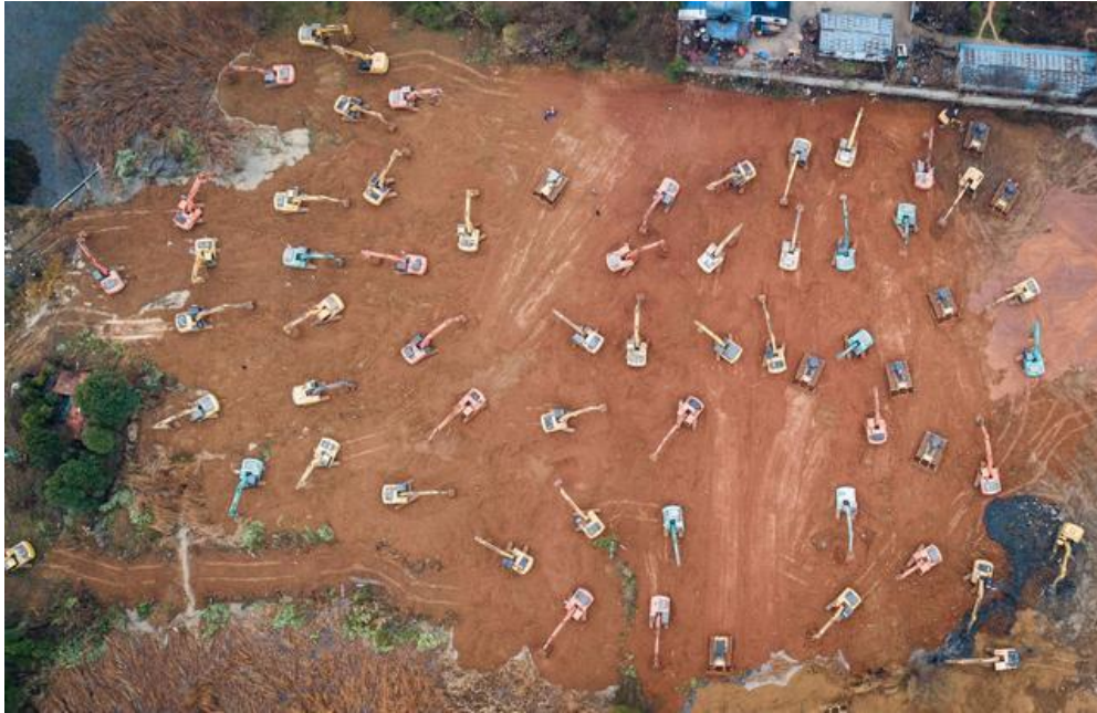
大型机械在武汉火神山医院建设工地施工（2020年1月24日摄，无人机照片）。
